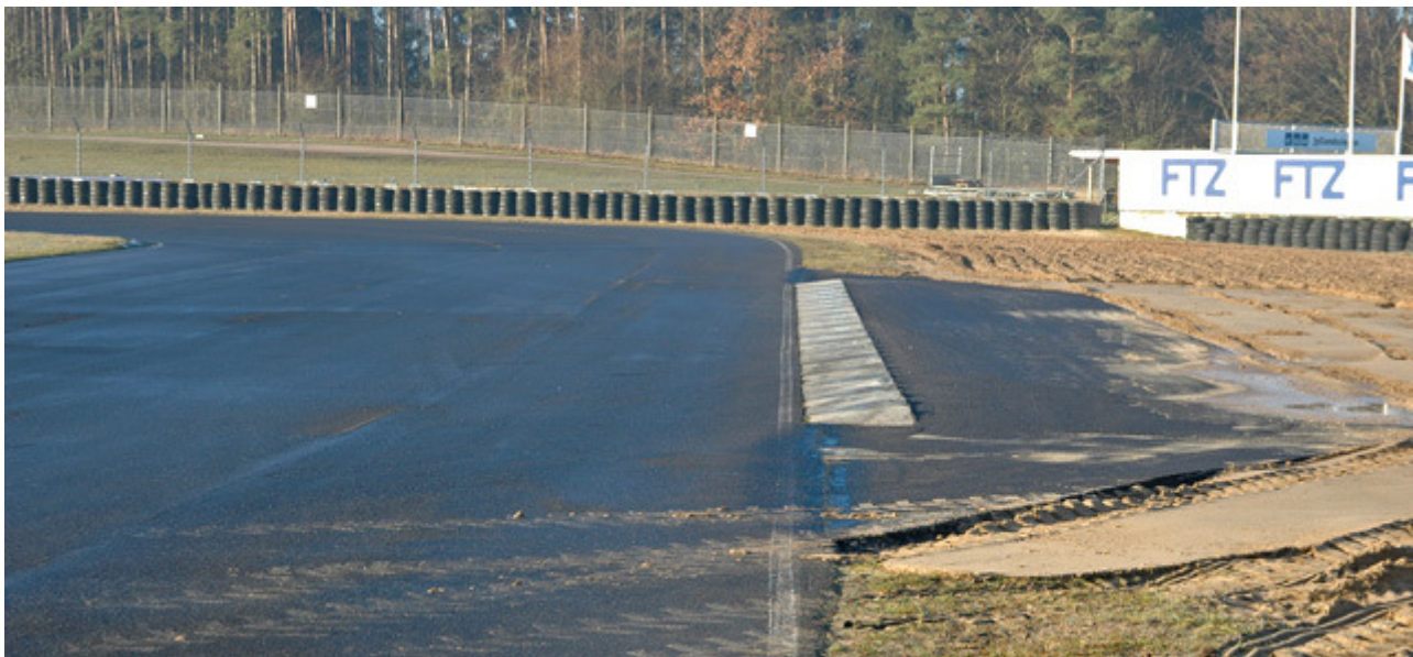
Ny afkørselsbane for enden af langsiden - foto Morten Alstrup
